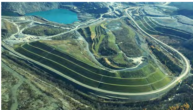
Figure 5.2.2 Végétalisation de haldes minières à Thetford Mines à l'aide de MRF (photo : Viridis Environnement)
