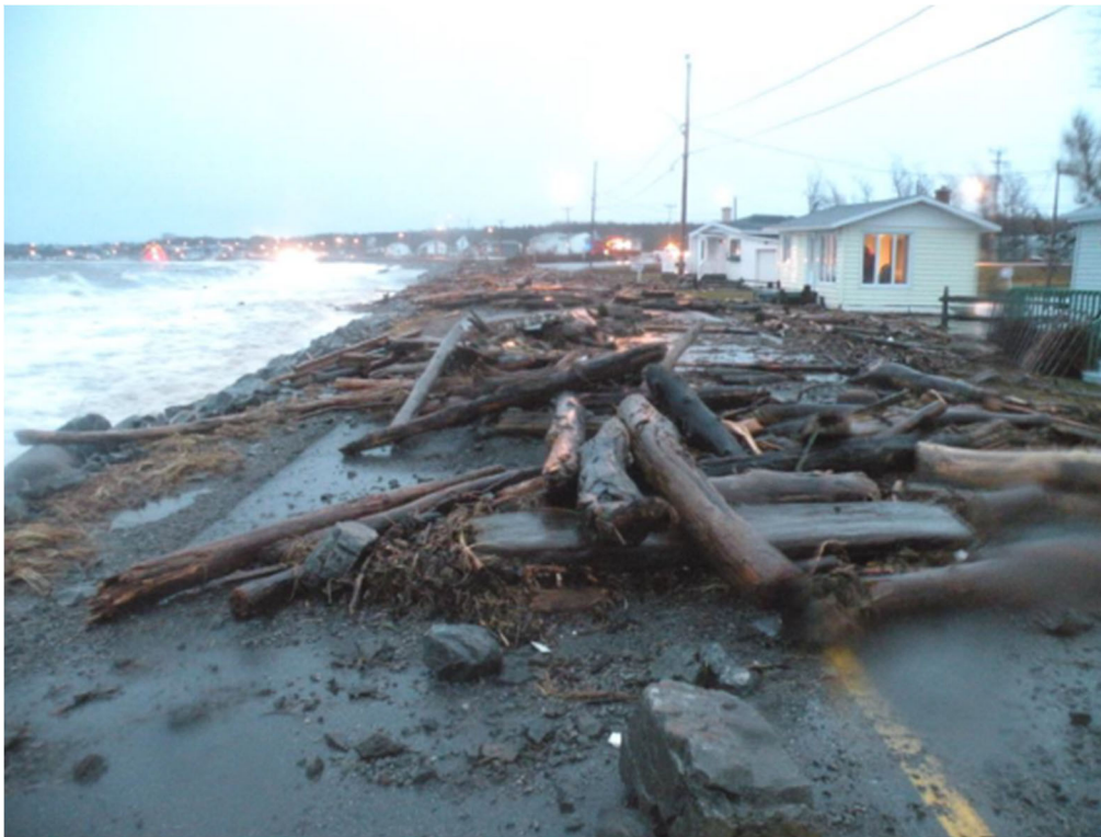
FIGURE 2 : PROJECTION DE DÉBRIS LORS DE LA TEMPÊTE DU 6 DÉCEMBRE 2010
