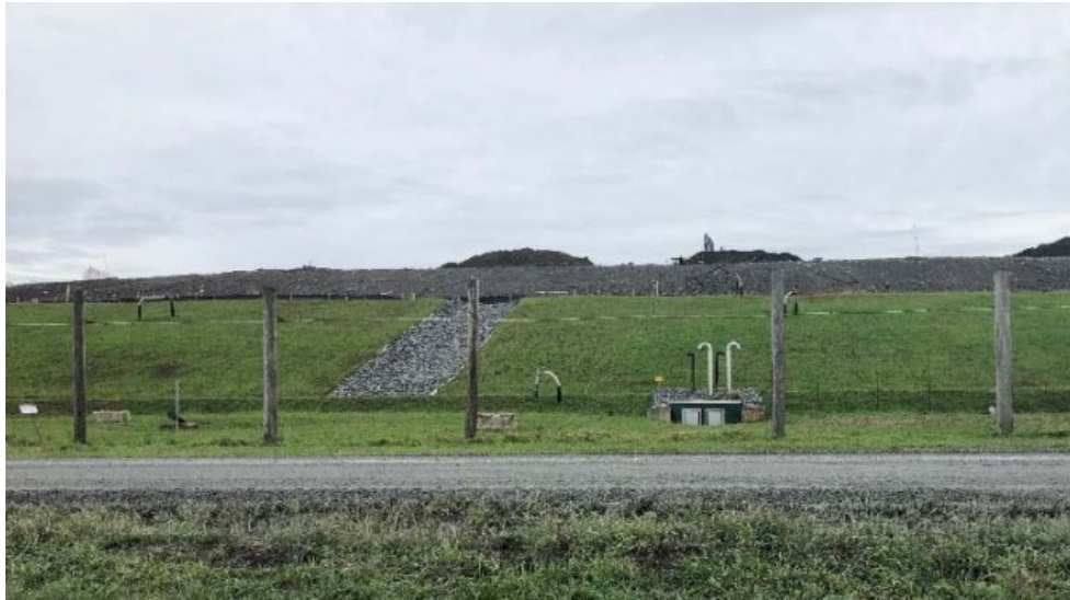
FIGURE 4 EXEMPLE D'UNE DESCENTE PLUVIALE
