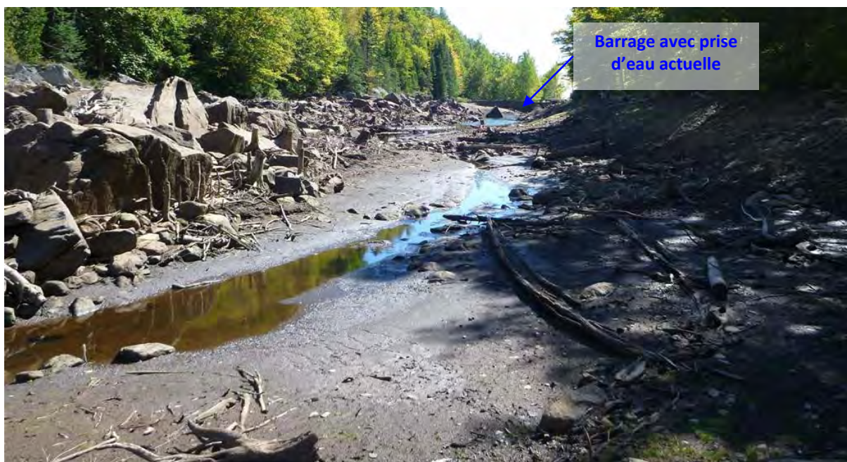
FIGURE 2 TRONÇON ENTRE LA LIMITE D'ORIGINE DU LAC ET LE BARRAGE EN SEPTEMBRE 2013
