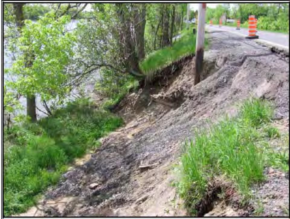
**Photo 2 :** Vue vers l'amont du glissement au site #1 (Saint-Marc-sur-Richelieu)
